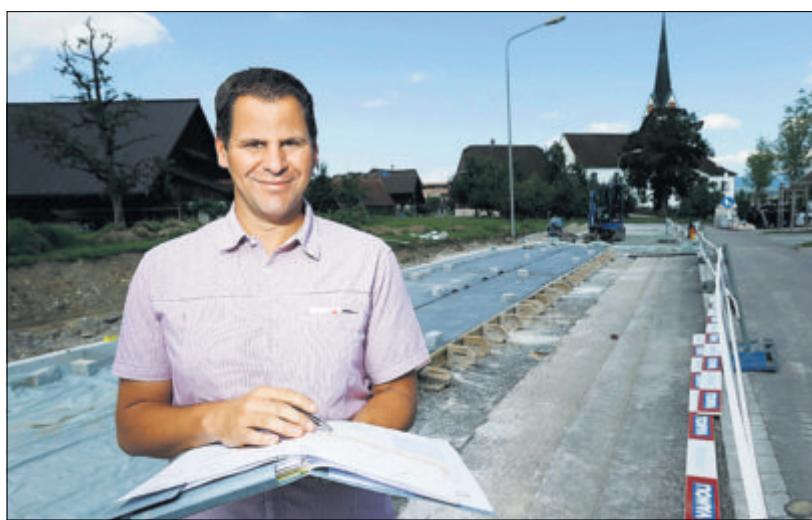
Der Sins Tiefbau-Verantwortliche Daniel Wachter steht auf der Schulhausstrasse. Sie wird umfassend saniert. Bild Stefan Kaiser
