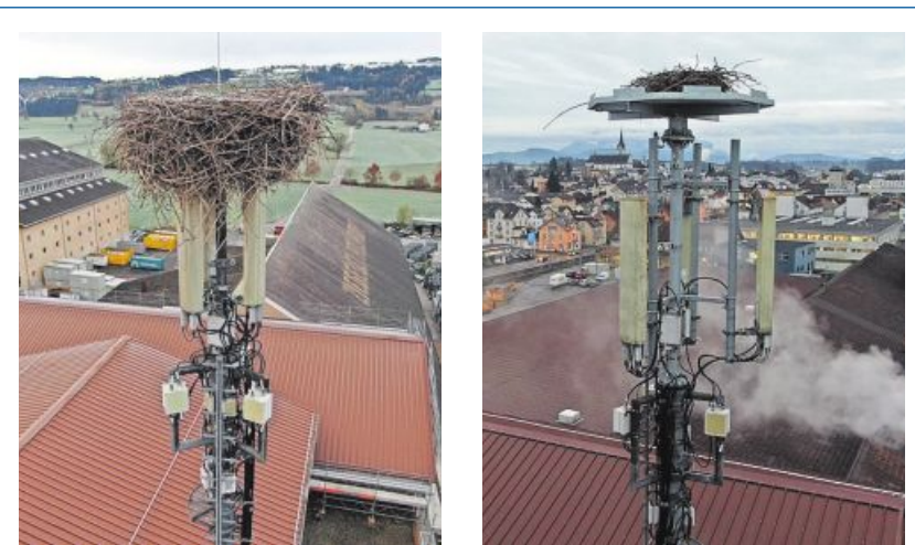
Das vorherige Storchennest (links) wurde zu schwer für die Mobilfunkantenne, weshalb eine neue Plattform installiert wurde (rechts). Fotos zvg
