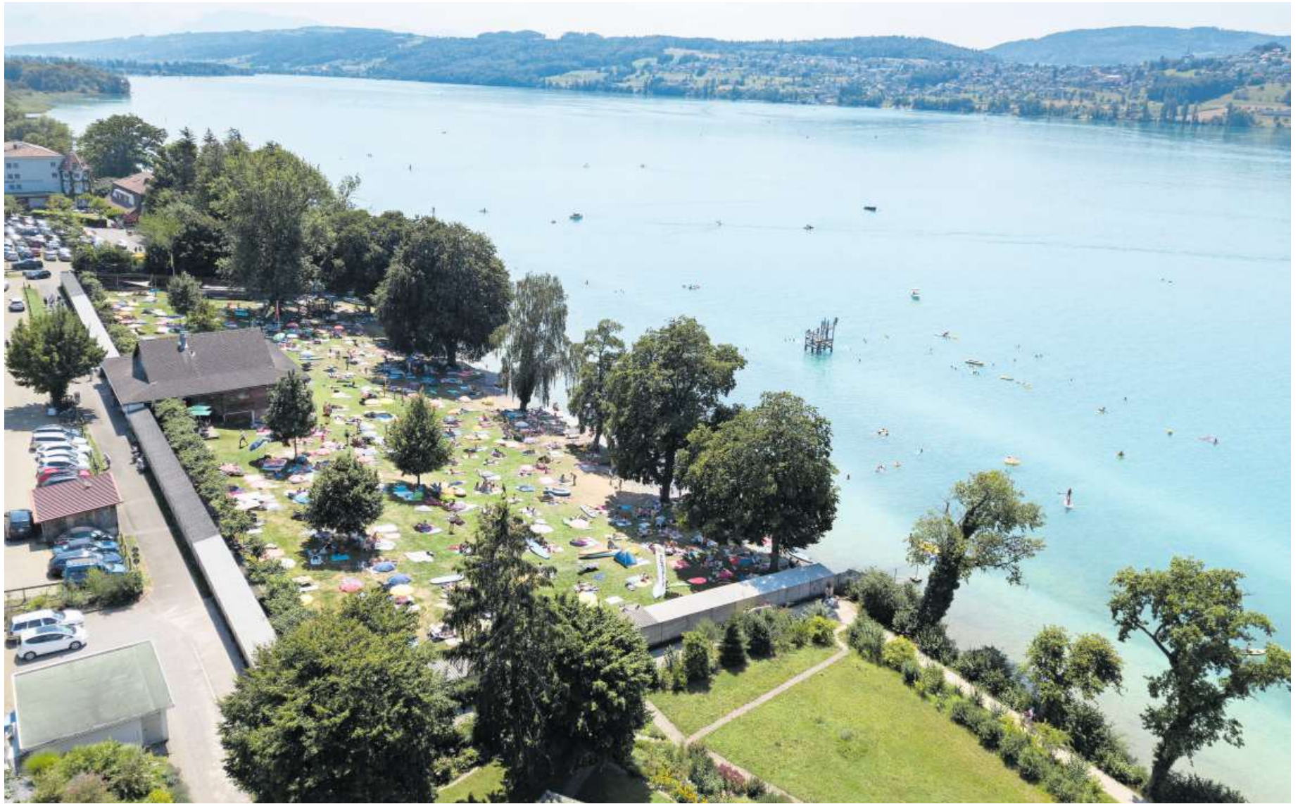
200 bis 300 Meter vom Ufer entfernt: In Meisterschwanden soll im Bereich des Strandbads Seerose ein Seewasserwerk realisiert werden.
