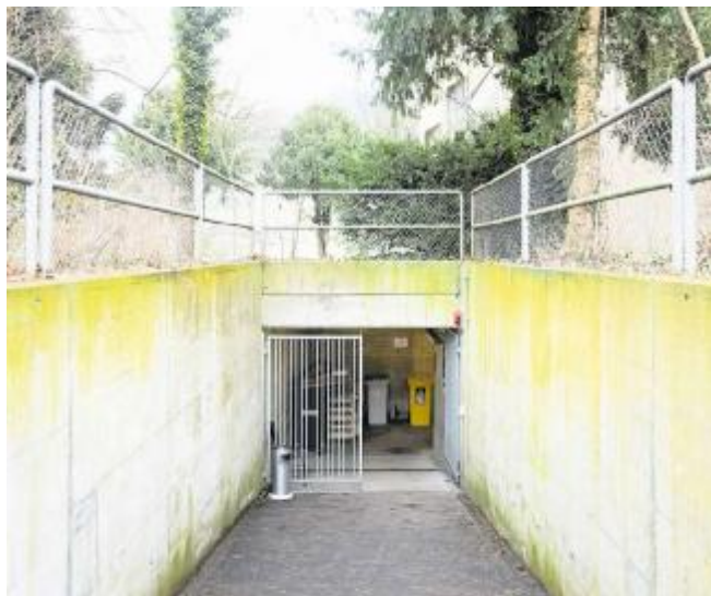
Die Zivilschutzanlage in Dagmersellen wird als Notunterkunft genutzt. Bild: Manuela Jans-Koch (4.1.2023)
